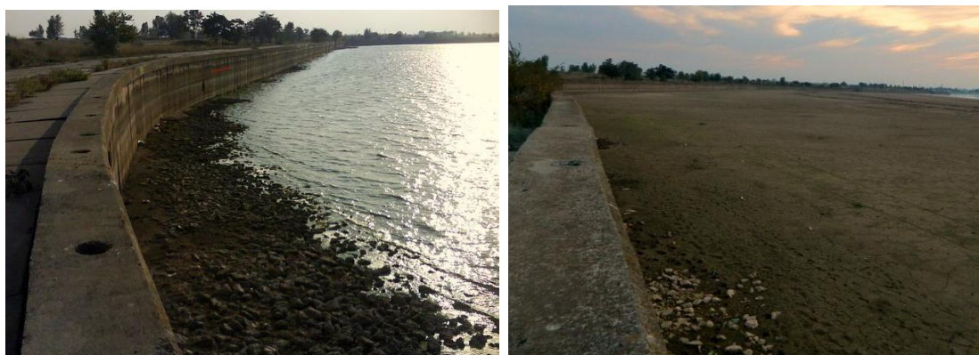
Рис. 5,6. Цимлянское водохранилище в 2009 году (слева) и в 2015 (справа)
